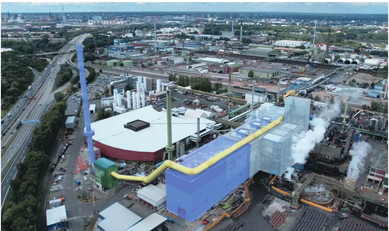
Blick auf das neue Abluftsystem (farblich markiert) am Standort Hamburg in unmittelbarer Stadtnähe
