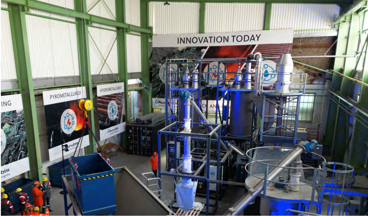
Pilotanlage in Lünen: Vorreiterrolle für neue Technologie.
